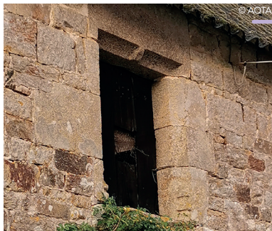
Fenêtre à linteau droit avec cavet et trace d'un meneau brisé. 6 rue des 3 Clochers, Plumergat
