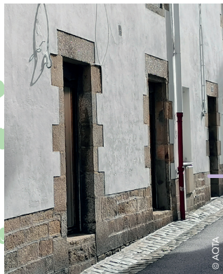
Mise en œuvre avec enduit
