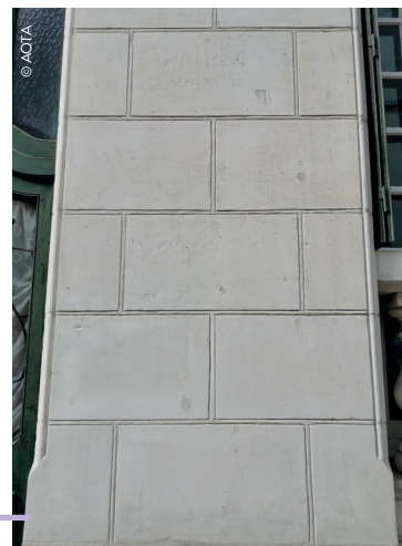
Mur en pierre calcaire
