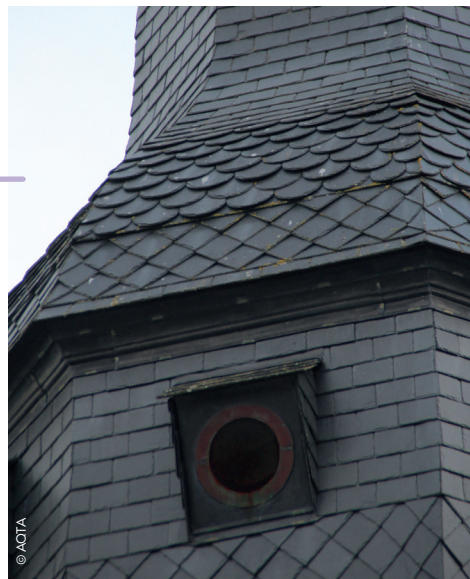
Toit en ardoise, église Saint- Thuriau de Plumergat
