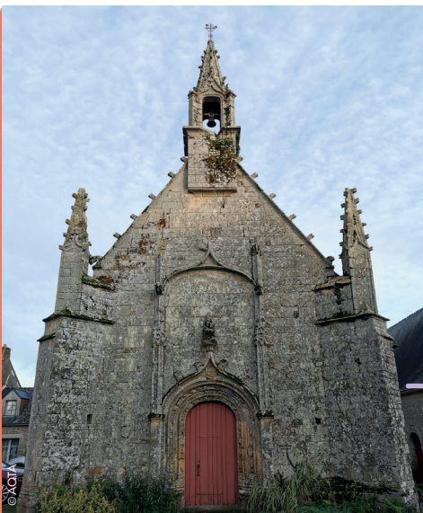
Chapelle de La Trinité, gothique flamboyant XVI e siècle, Plumergat
