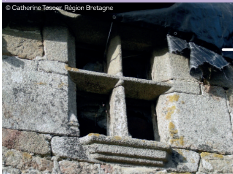
Fenêtre à croisée, ferme de Kerveno le Val, Landévant
