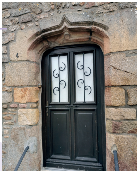
Porte avec arc à accolade, 4 rue de l'Église, Landévant
