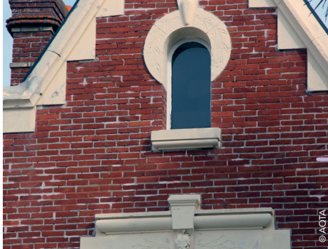
Mur en briques
