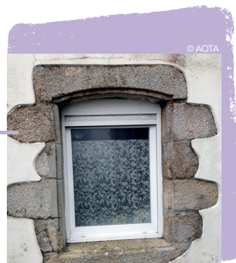
Fenêtre à linteau en arc segmentaire, Landévant
