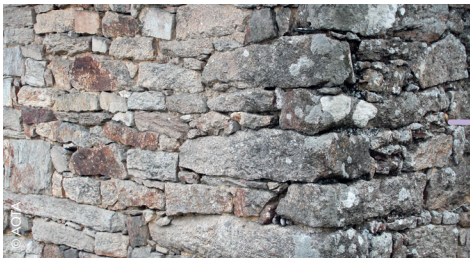
Mise en œuvre en moellon
