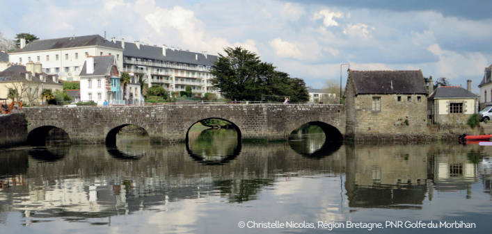
Pont de Saint- Goustan, Auray
