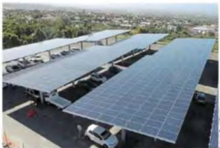
L'installation d'ombrières photovoltaïques sur les parkings de la piscine Alre'O est à l'étude.
