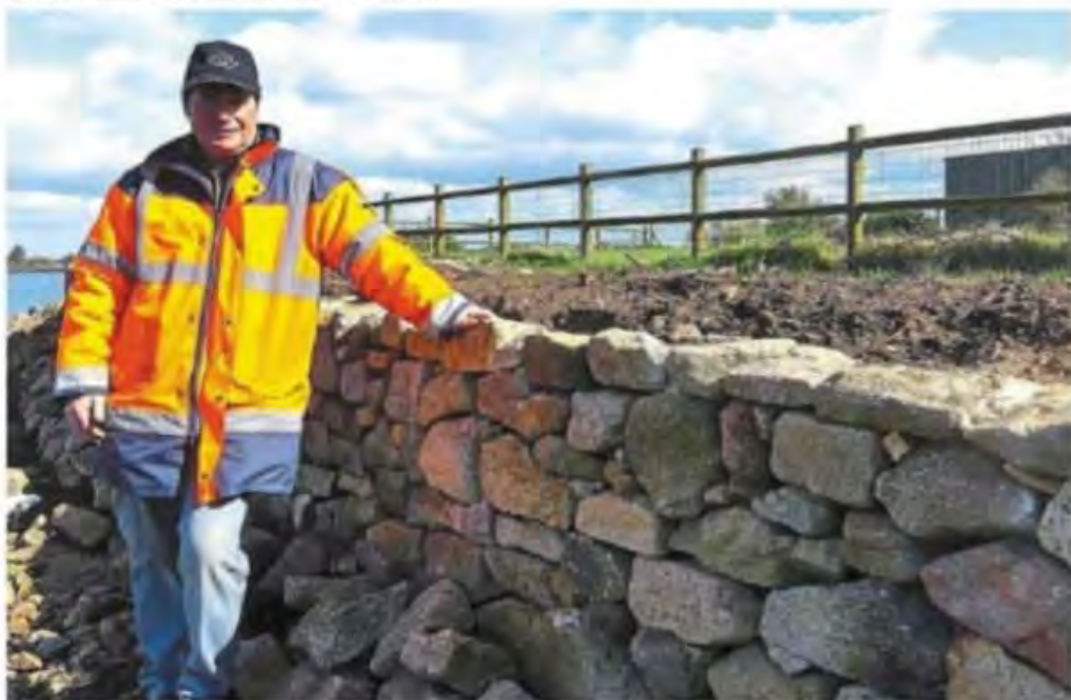
Philippe Le Stunff, encadrant technique, devant le muret de 45 m de long qui a été refait intégralement.
