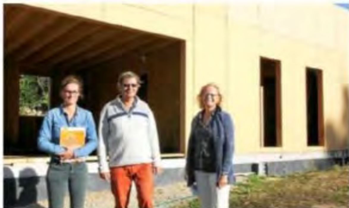
Mathilde Limbour, conseillère info énergie de la Maison du logement, avec M. et Mme De Belloy, devant leur maison en ossature bois, en construction.
