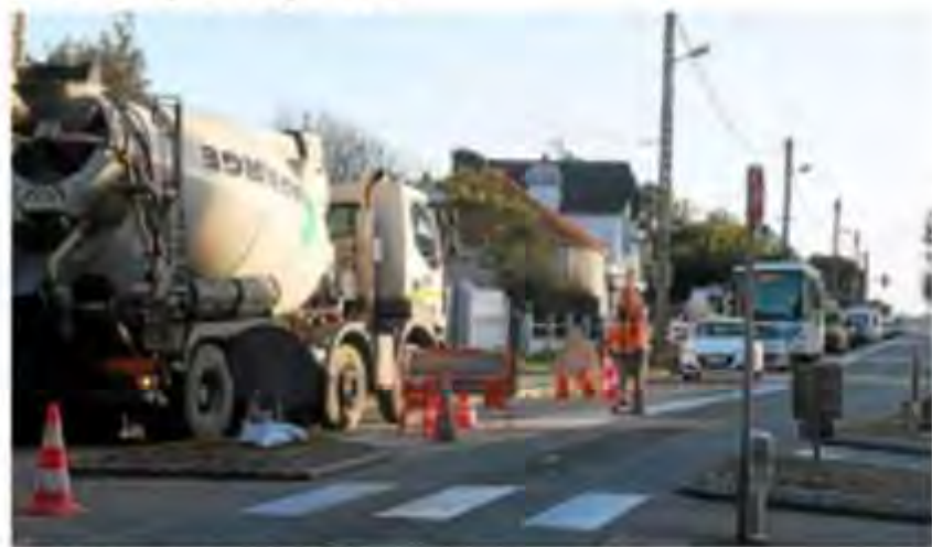
En raison des travaux sur les canalisations, la circulation est alternée pour aller sur la presqu'île.
