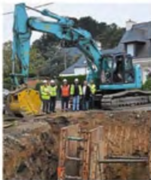
Les élus et les responsables du chantier sur le site du Ranguhan.
