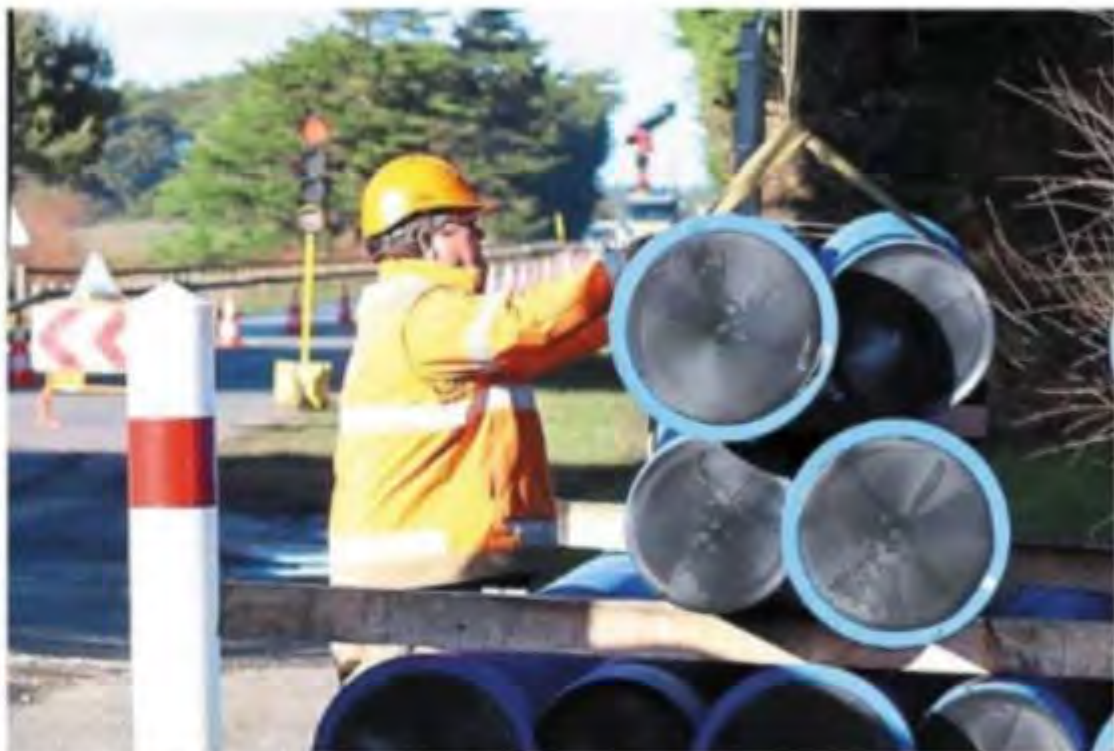
Lors de la préparation du chantier la semaine passée.
