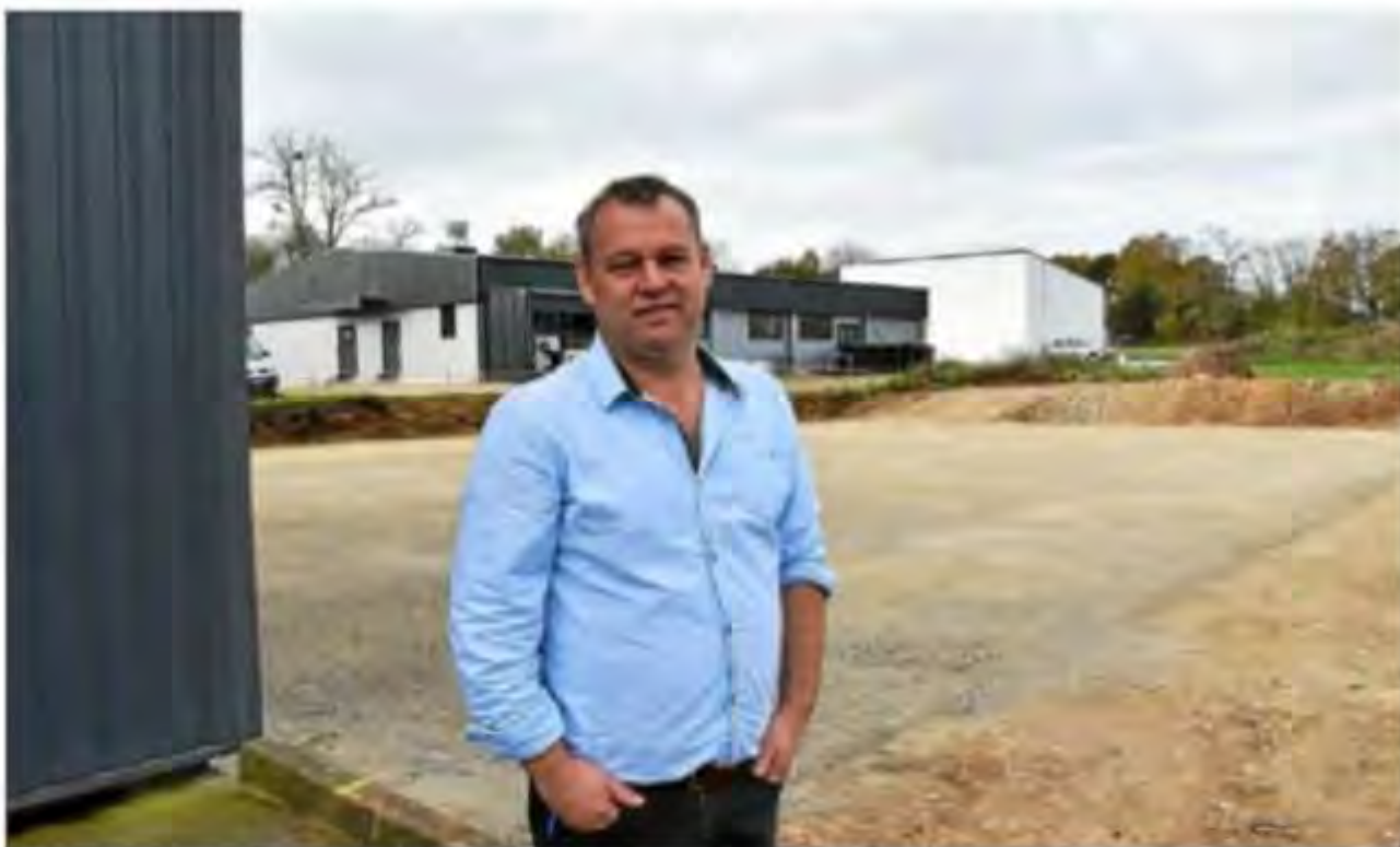
Le chantier de l'extension de l'entreprise de Stéphane Bruzac, MPO, a pris un peu de retard dû fait des intempéries hivernales.
