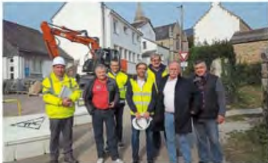
Représentants des entreprises, de la commune et de la communauté de communes étaient présents, ce jeudi, sur le chantier, route de la Grotte.
