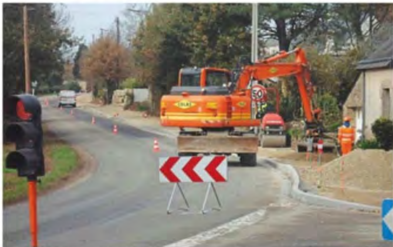
La liaison douce démarre dans ce virage de Coët-er-Harv. La piste monte progressivement jusqu'à l'intersection avec la rocade.
