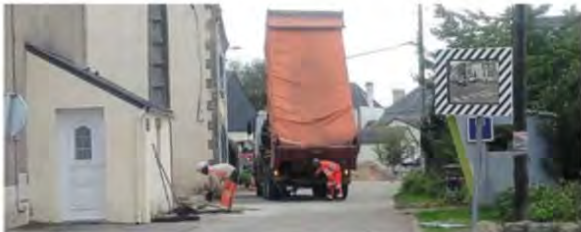
Les travaux ont démarré depuis fin septembre dans le secteur du Pont-Lorois. Ils vont durer quatre mois.
