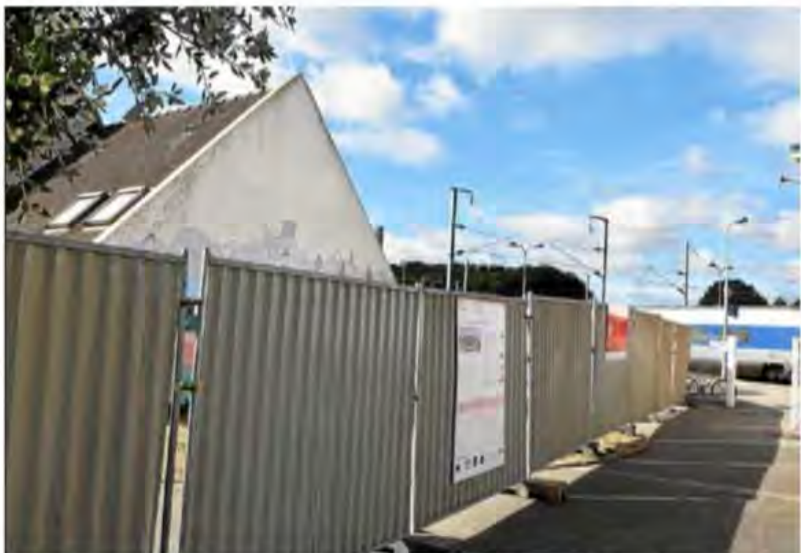
La première phase de travaux a débuté le lundi 10 septembre, avec la mise en sécurité du bâtiment « train-auto-couchettes », qui sera bientôt déconstruit (Jean-Benoît)
