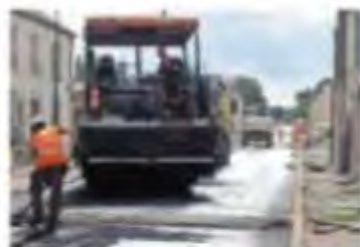
Les travaux se poursuivent.
