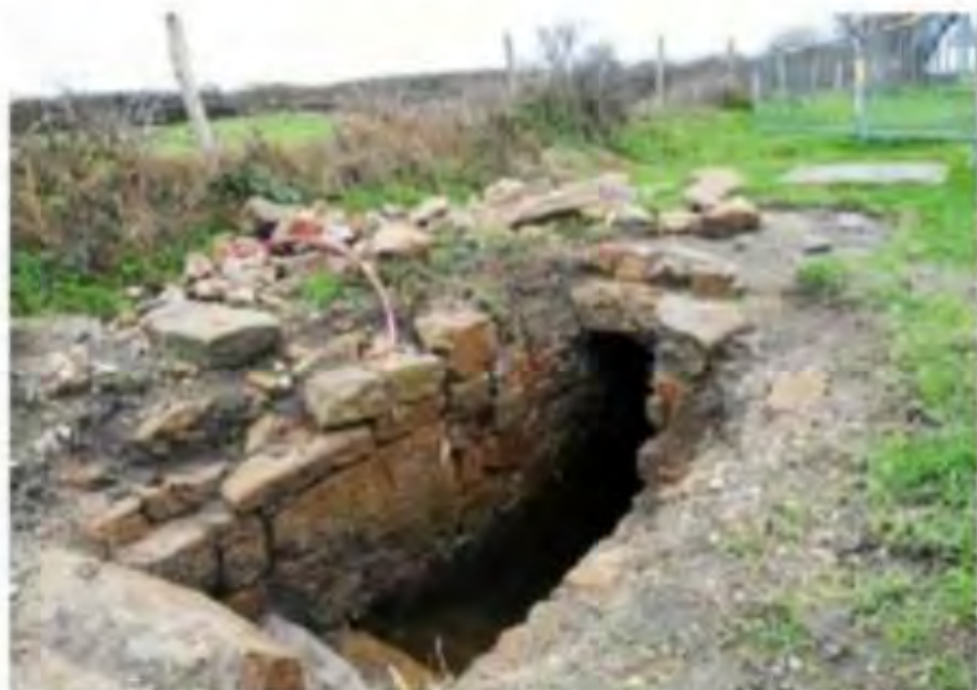
La réhabilitation de la fontaine est programmée pour 2019.
