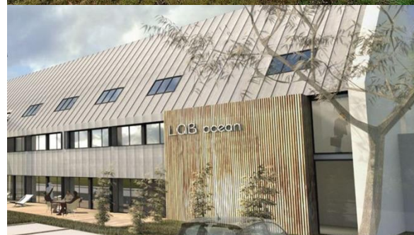
Le bâtiment de l'IFREMER avant/après (source : La Compagnie des Ports du Morbihan)
