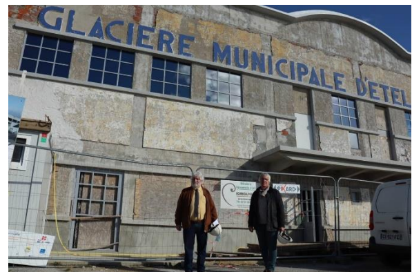
Le chantier de la Glacière en novembre 2021 (Crédit Photo : Ouest France)
